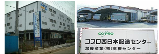
コプロ東日本および西日本配送センター
